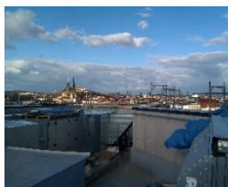
vysoká atika skrývá technologie na střeše a přispívá ke kultivované stavbě i městskému prostředí
