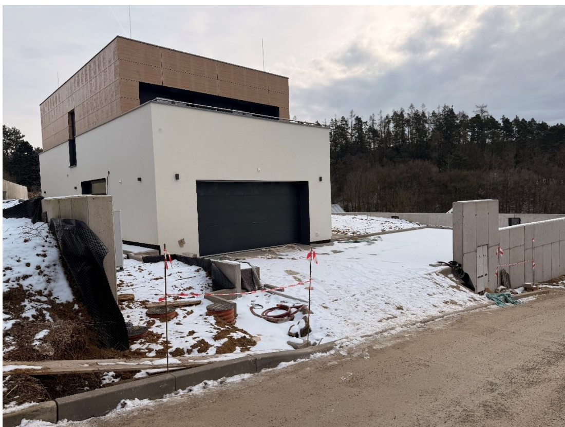
Obrázek 21 - Výstavba RD na pozemku p.č. 170/7 v k.ú. Ořešín
