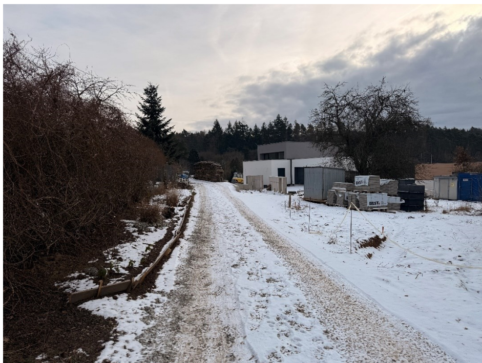
Obrázek 20 - Výstavba RD na pozemku p.č. 170/9 v k.ú. Ořešín
