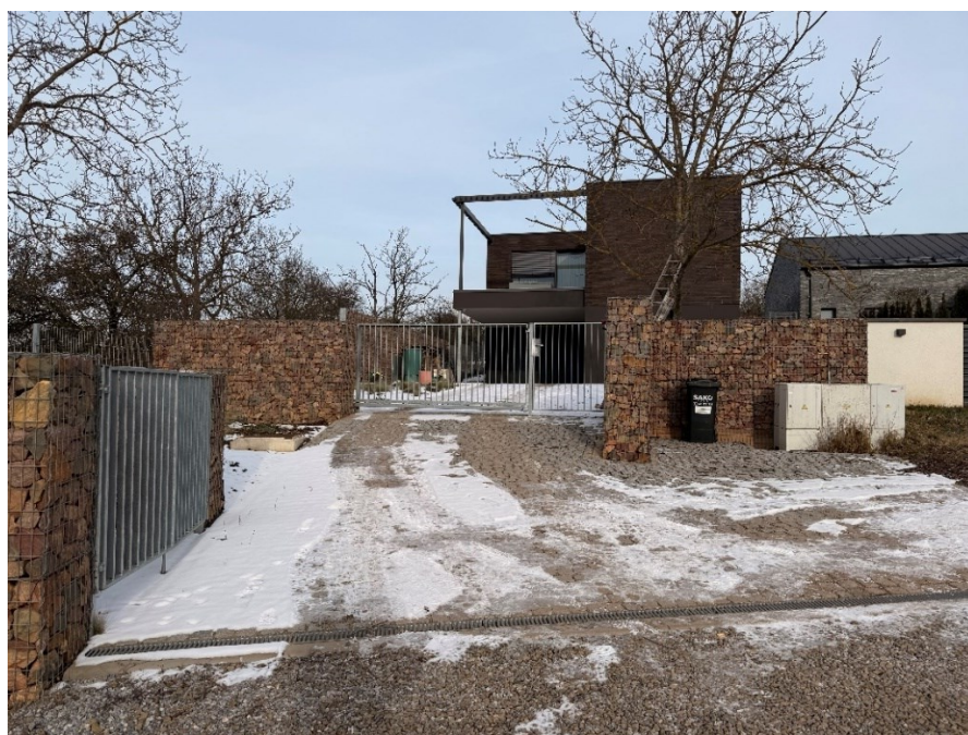
Obrázek 23 - Výstavba RD na pozemku p.č. 187/1 v k.ú. Ořešín
