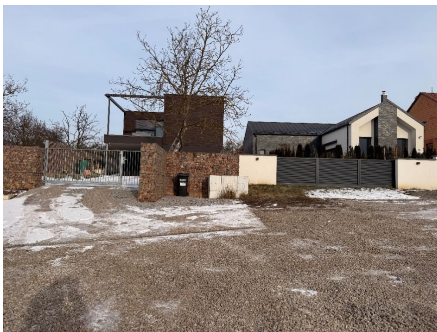
Obrázek 22 - Výstavba RD na pozemcích p.č. 185/4, 184/10 a 184/9 v k.ú. Ořešín
