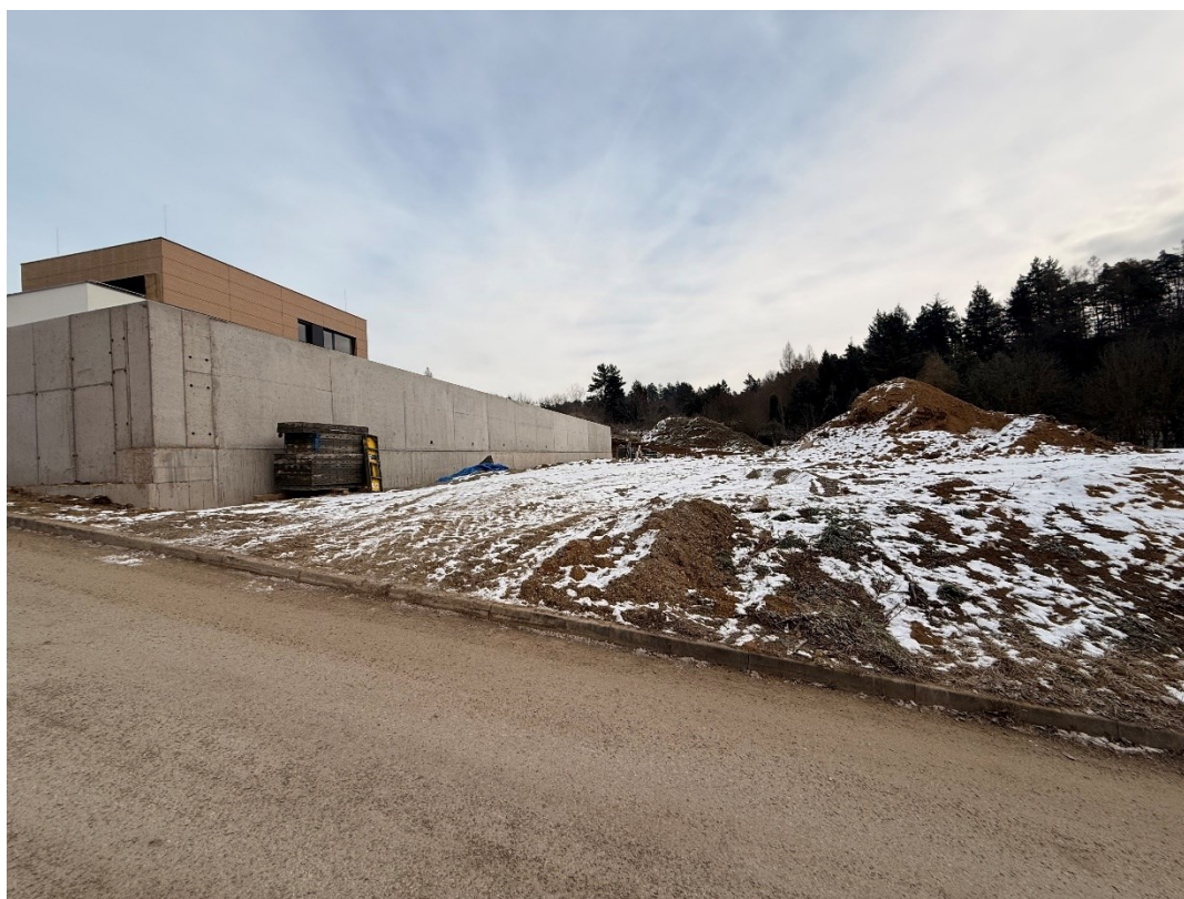
Obrázek 24 - Výstavba 2 RD na pozemcích p.č. 169 a 170/1 v k.ú. Ořešín – úprava pozemku
