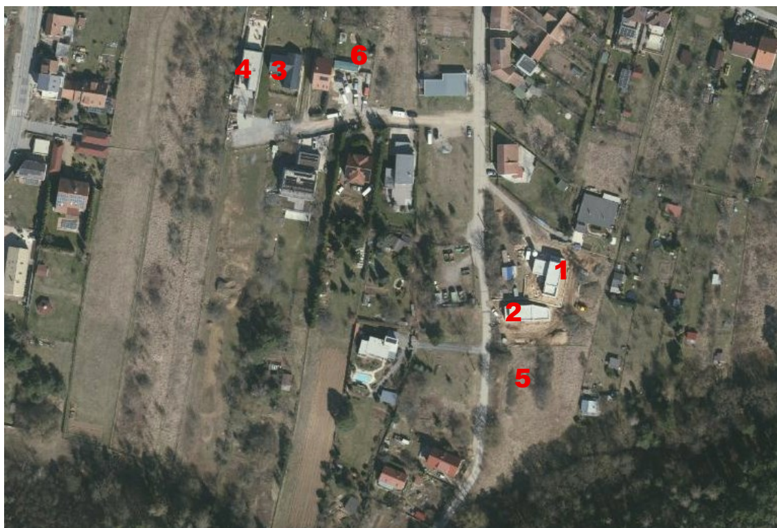
Obrázek 19 Letecký snímek řešeného území – 2025 s vyznačením probíhající výstavby
