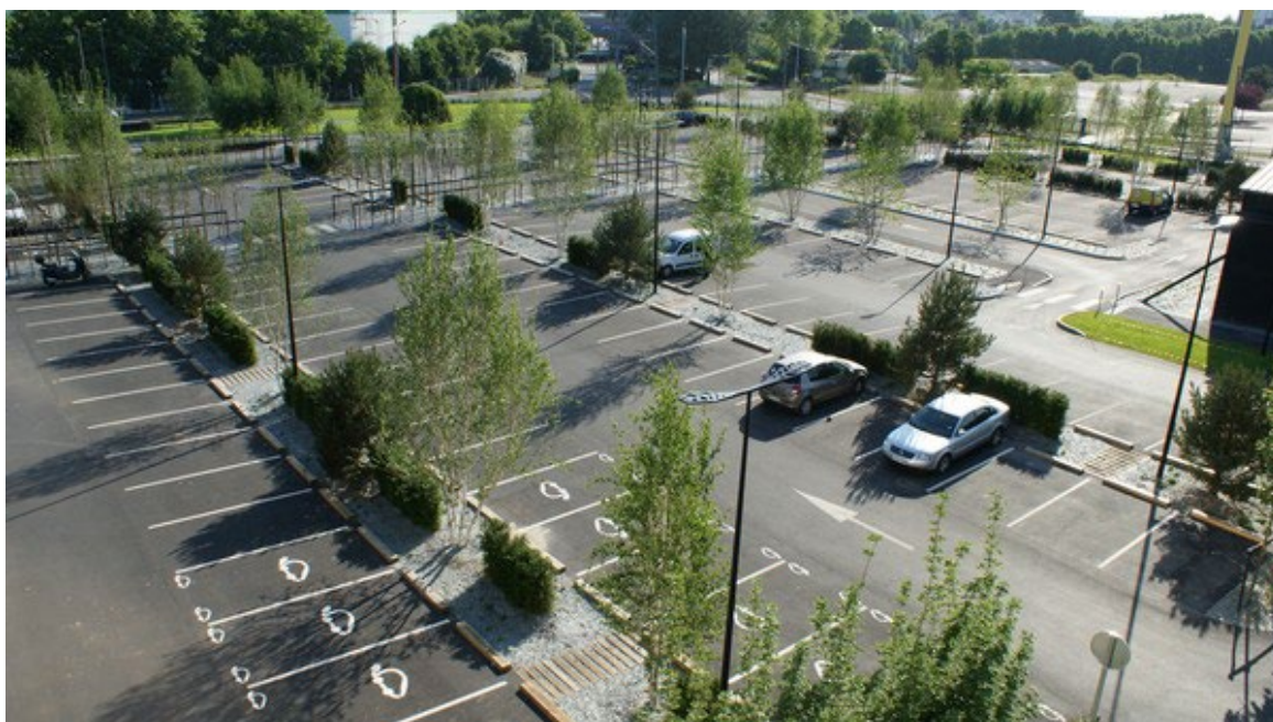
Obr.11 Parkoviště nákupního centra Enox, GENNEVILLIERS-Paříž, Francie. Zdroj: Koncepce vodohospod. řešení „Multifunkční sportovní a kulturní centrum“ (AQUATIS a.s., JV PROJEKT VH s.r.o., 03/2020)
