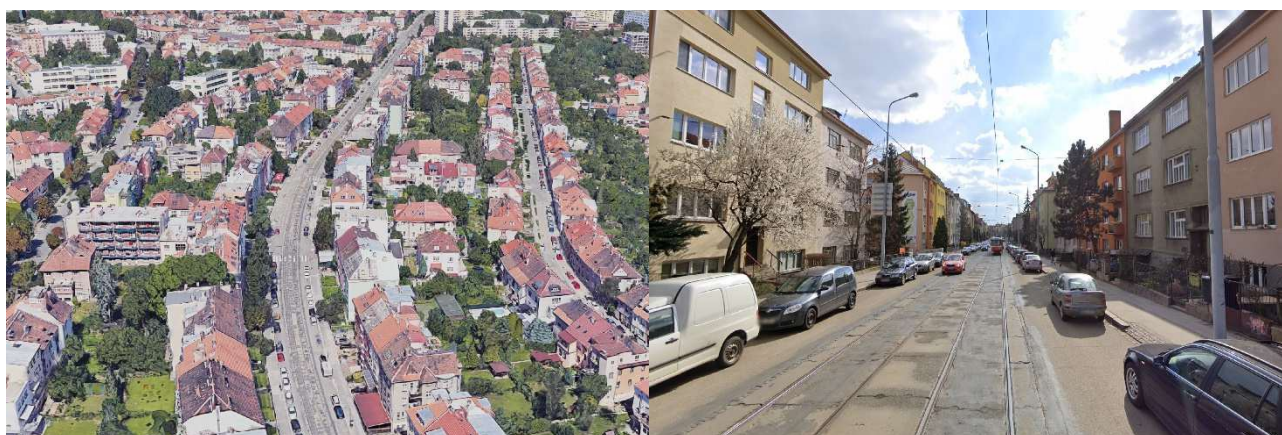
Obr. 46 Ulicí Merhautova je vedena tramvajová trasa, avšak ulice nikdy nebyla koncipována jako městská nebo obchodní třída. Parter objektů je jen výjimečně určen pro obchod a služby. Stavební čára bytových domů je často odstoupena od uliční čáry o pás předzahrádek, které jsou oploceny nebo od chodníku odděleny živými ploty. Potenciál významnější ulice je patrný pouze v bezprostřední blízkosti občanských staveb typu škola, kterých je na Merhautové hned několik (Střední zdravotnická a Vyšší odborná zdravotnická škola, základní škola, mateřská škola).
