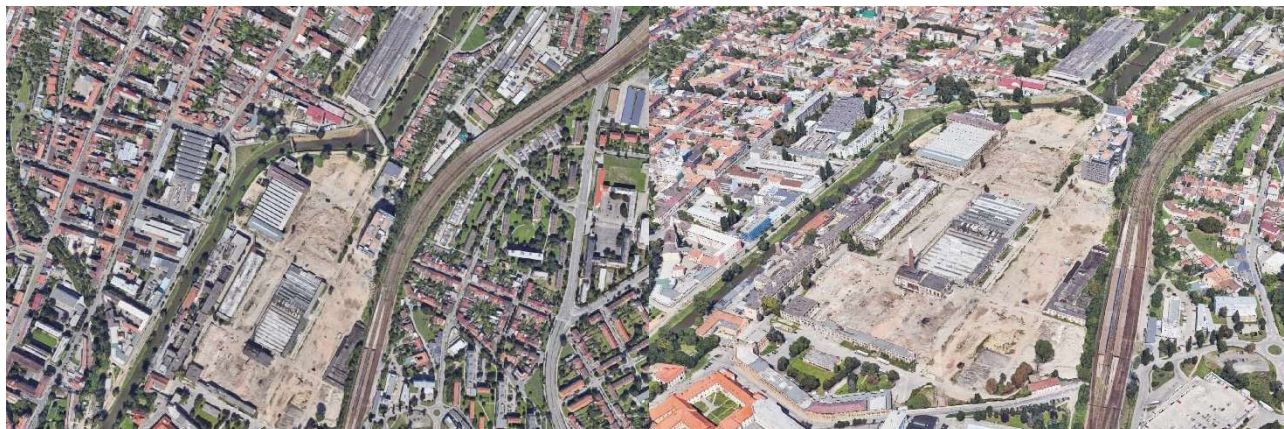
Obr. 40 Příklad výškové hladiny 6: oblast Zbrojovka a Motorárna
