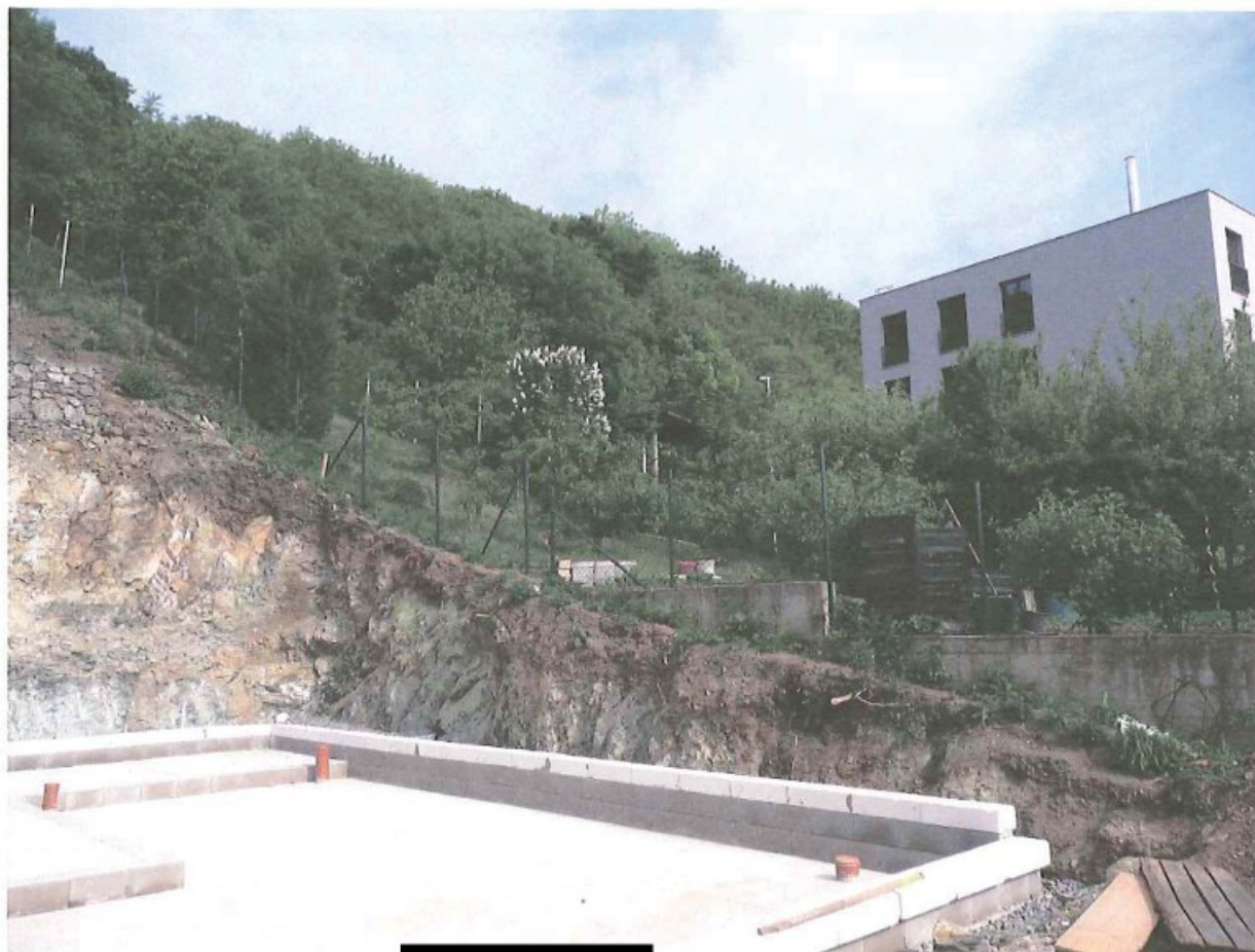
Skalnaté podloží nad základy [redacted] a sklon svahu směrem k lokalitě Zy-3 dle NÚP
