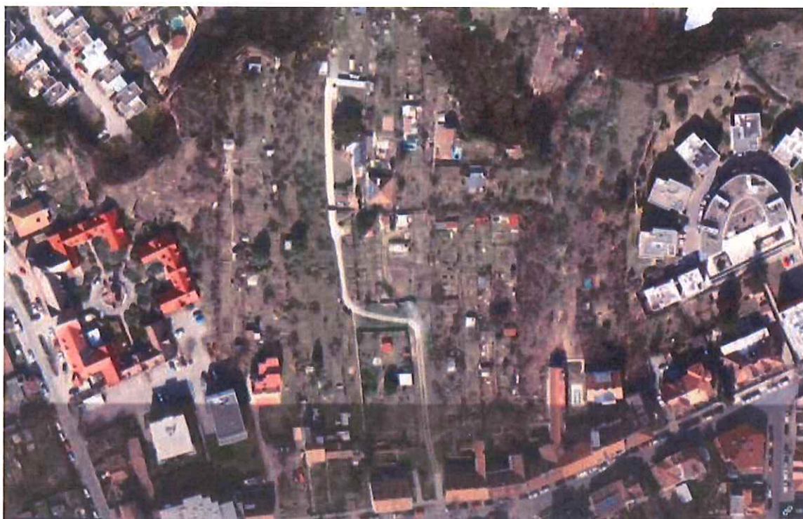
Obrázek 8- stávající stav účelové komunikace v dané lokalitě
