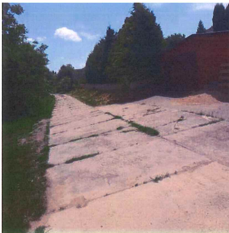
Obrázek 11 - fotodokumentace dotčeného území (pohled na pozemky parc. č. 1012/11 a 1012/30)
