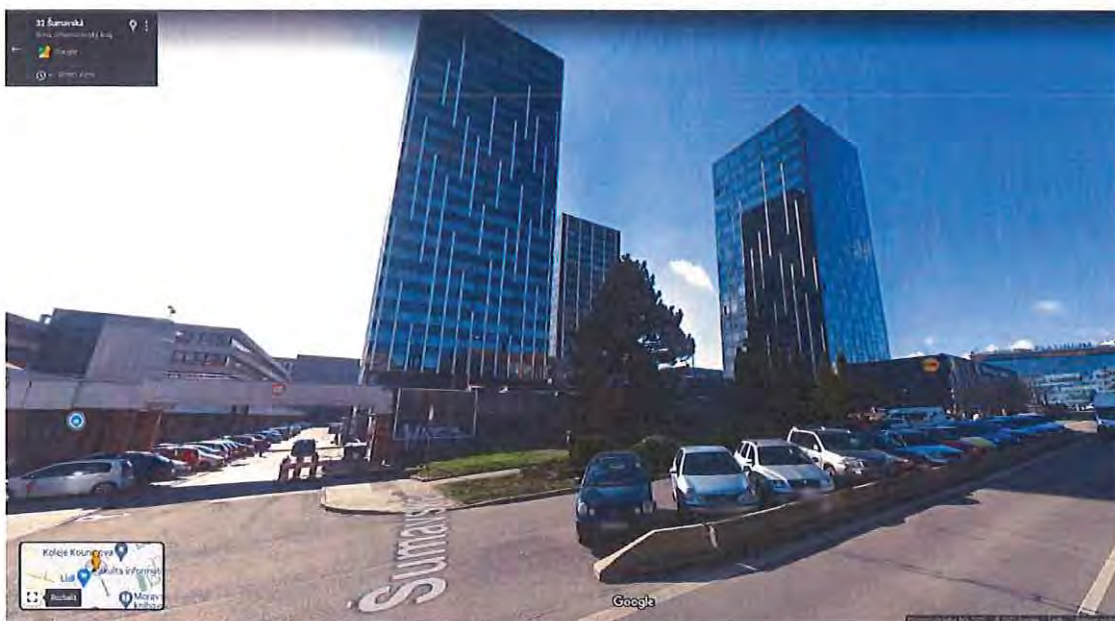
Obrázek č. 10 – Stávající budovy dle GOOGLE (dostupné z https://www.google.com/maps )
