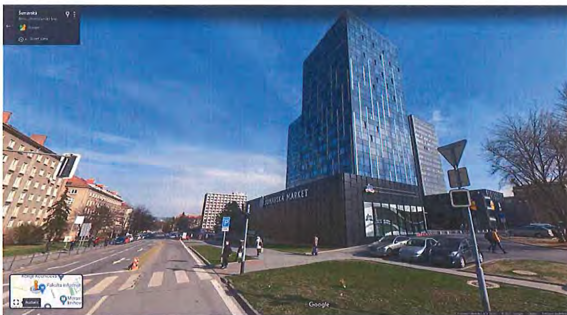
Obrázek č. 9 – Stávající budovy dle GOOGLE (dostupné z https://www.google.com/maps )
