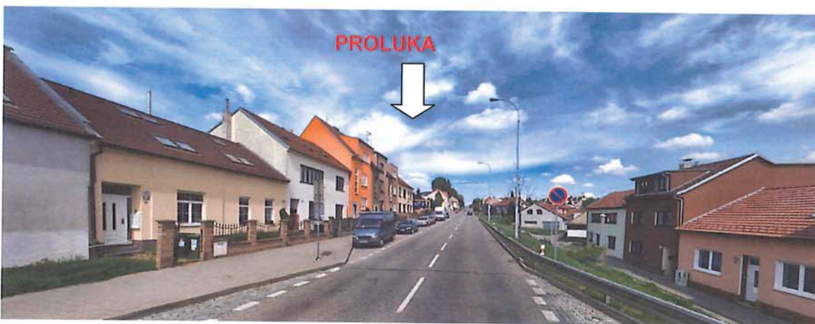
obr. 13) fotografie řadové zástavby rodinných domů, ul. Terezy Novákové
