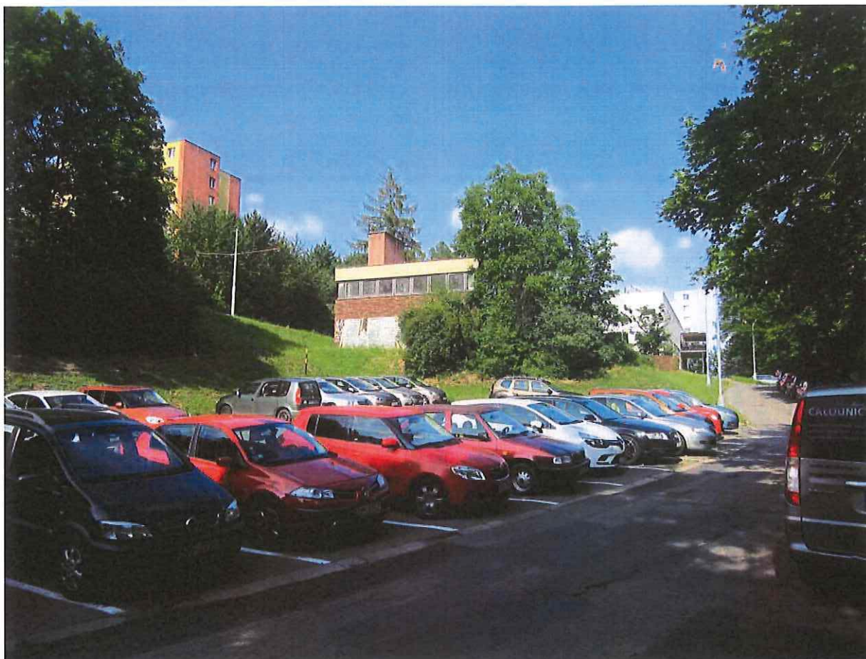
Urbanisticky významný objekt OC je skrytý za blokovou kotelnou
