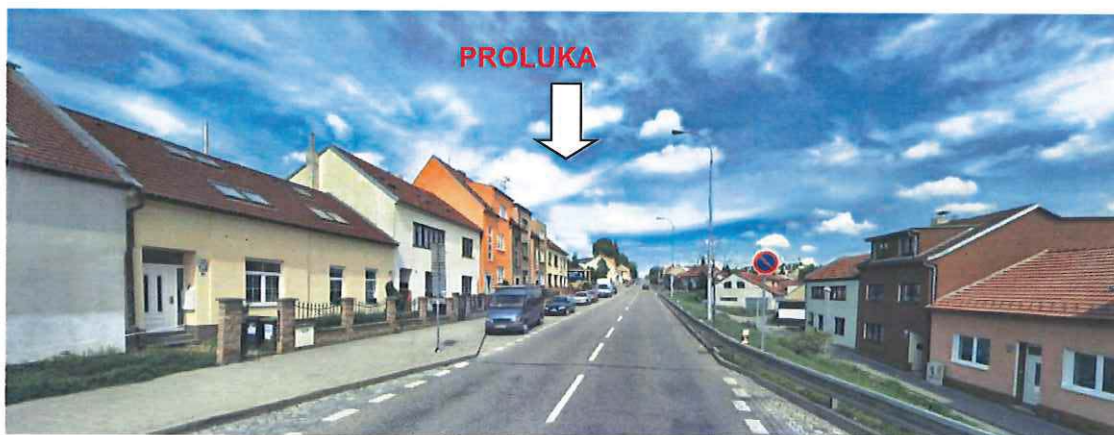
obr. 13) fotografie řadové zástavby rodinných domů, ul. Terezy Novákové
