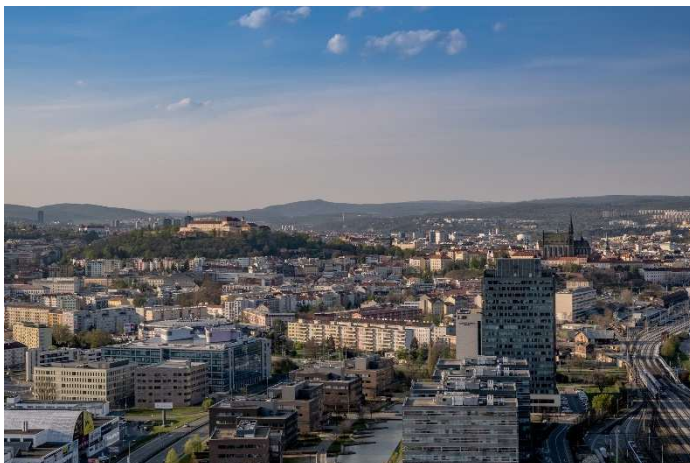
Pohled z AZ TOWER (KAM, 2020) směrem ke Špilberku a Petrovu. V záběru je dominantní hmota objektu Spielberk Tower 2.
