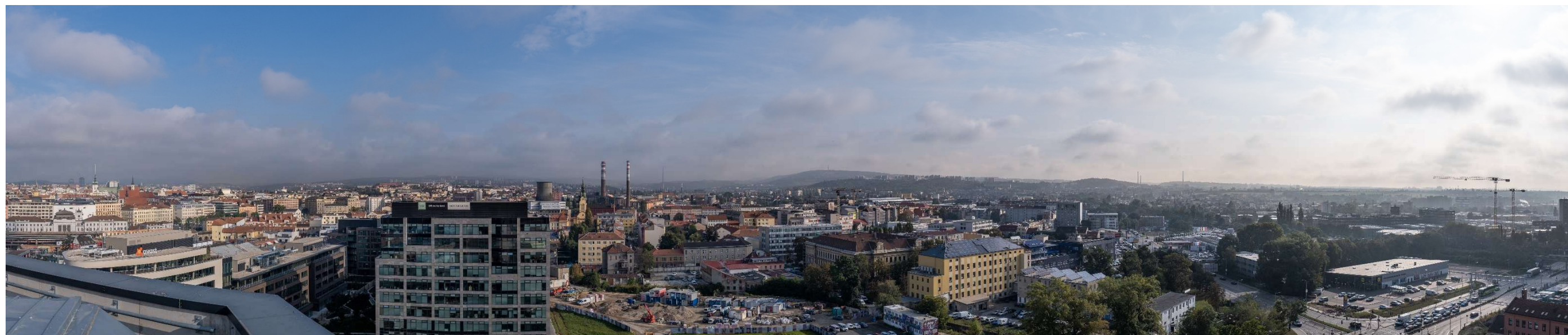
Pohled ze střechy objektu DORN na Dornychu (KAM, 2020).
