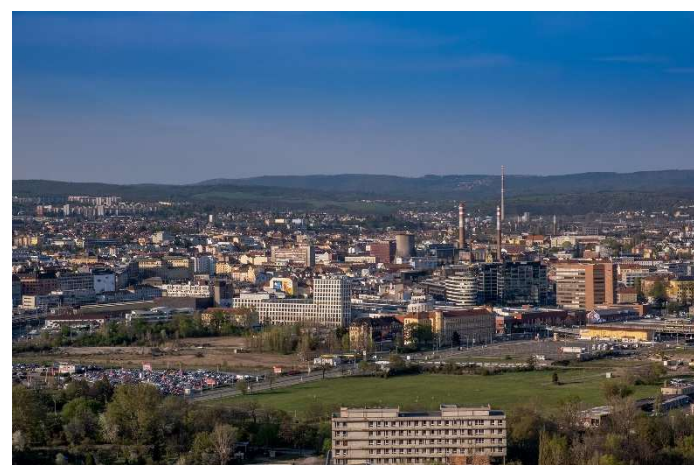
Pohled z AZ TOWER (KAM, 2020) směrem k výškovému objektu DORN. V popředí budova železniční polikliniky, která nebyla nikdy dostavěna. 30 let rozestavěná stavba bude odstraněna a místo ní vznikne podél řeky Svratky povodňový park, který je součástí přírodně blízkých protipovodňových opatření. Zelená plocha se zpevněnou plochou (původní autobusové nádraží – předchůdce Zvonařky) je území pro výstavbu nové Jižní čtvrti.
