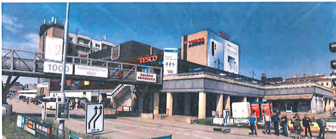
10/ DORNYCH, POLYFUNKČNÍ KOMPLEX, BRNO – STŘED
