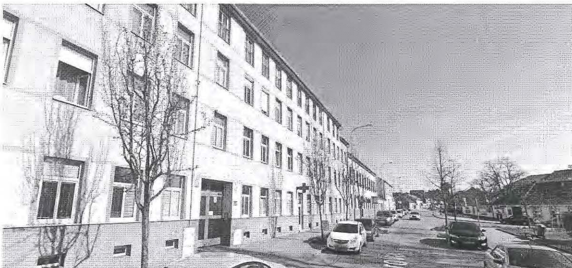
Fotodokumentace ulice Jamborova, zdroj Google.com
