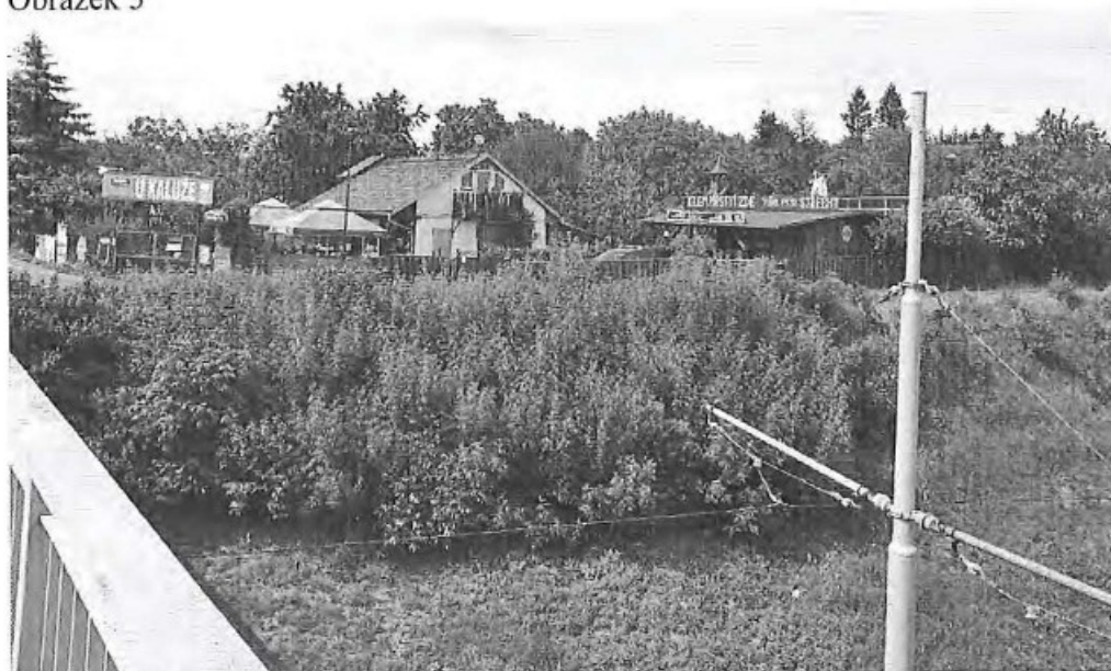
Detail části : dotčené parcely - pohled z mostu tramvajové tratě, dotčené parcely končí nad koridorem tramvajové tratě.
