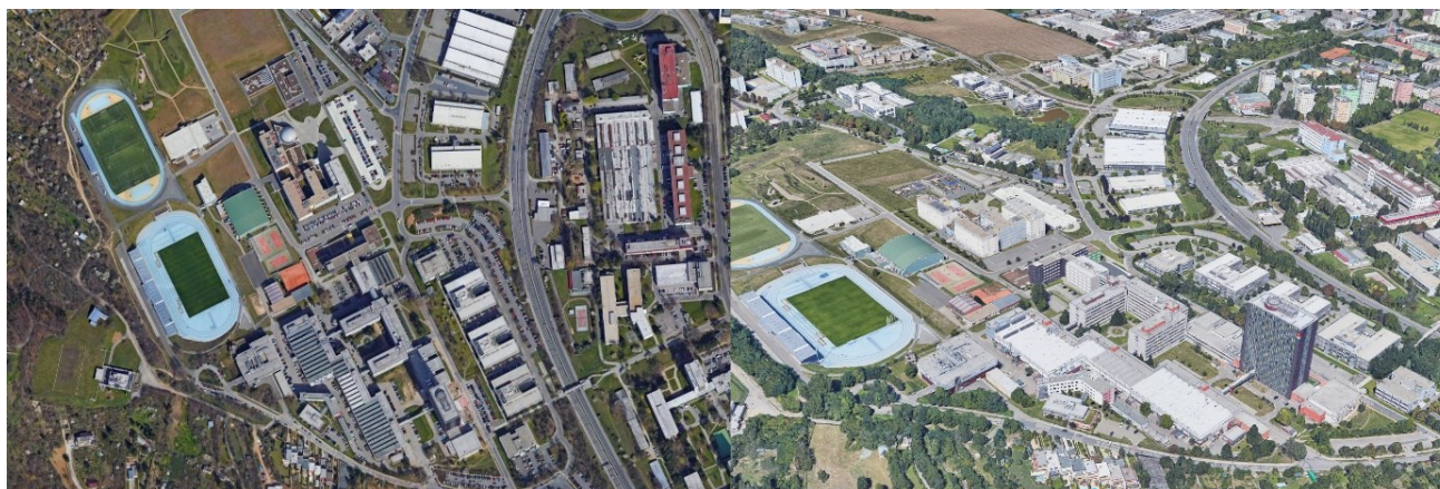
Obr. 28 Příklad sousedství dvou areálů v Králově Poli; Českého technologického parku a areálu VUT v Brně. Příklad různorodé struktury s ohledem na typ a velikost budov, sportovní stavby a hřiště jsou součástí areálové struktury.
