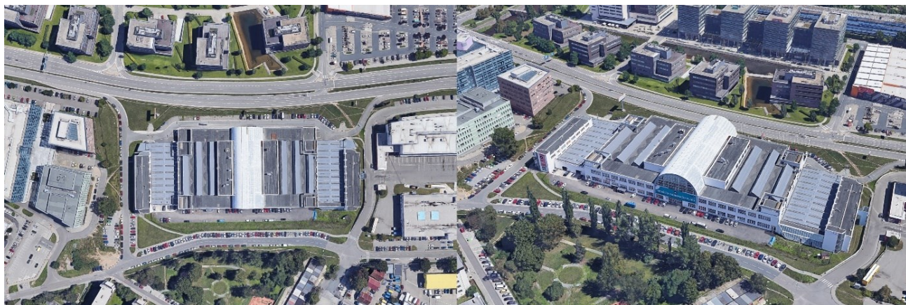
Obr. 22 Příklad, kdy volná struktura zástavba v ploše RZV je tvořena jedním objektem. Příkladem je budova bývalé typografie při ulici Heršpická.
