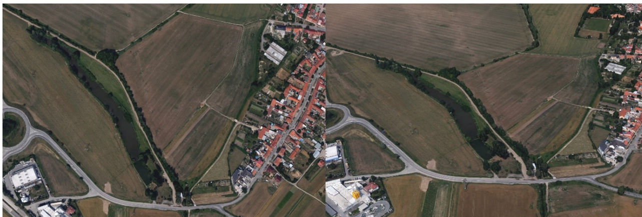
Obr. 32 Znárodnuje oblast tzv. chrlického poldru; v plochách rekreace mezi stávající zástavbou a plochou pro řízený rozliv je možné v omezené míře (10 %) plochy vymežit potřebnému zázemí.
