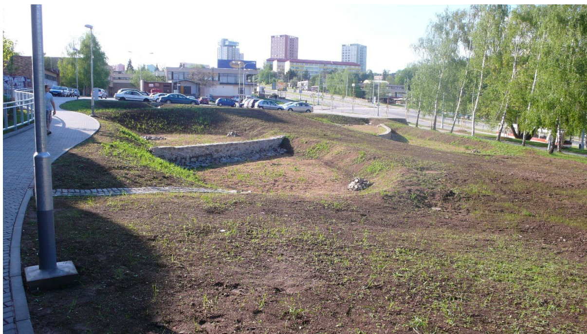
Obrázek 3: Vsakovací průleh po dokončení
