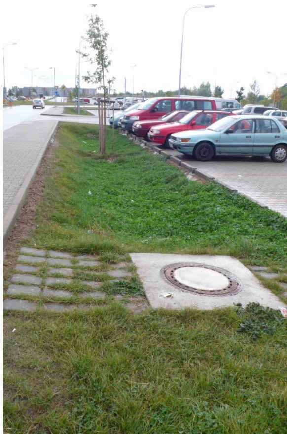
Obrázek 11: Vsakovací průleh k odvodnění parkoviště
