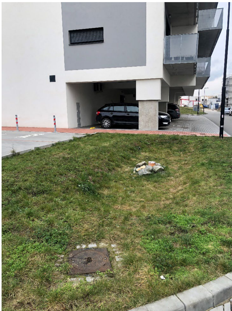
Obrázek 16: Zasakovací průleh s rýhou pro parkoviště
