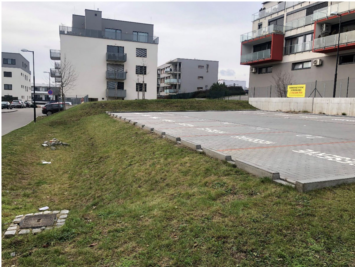
Obrázek 15: Zasakovací průleh s rýhou pro parkoviště
