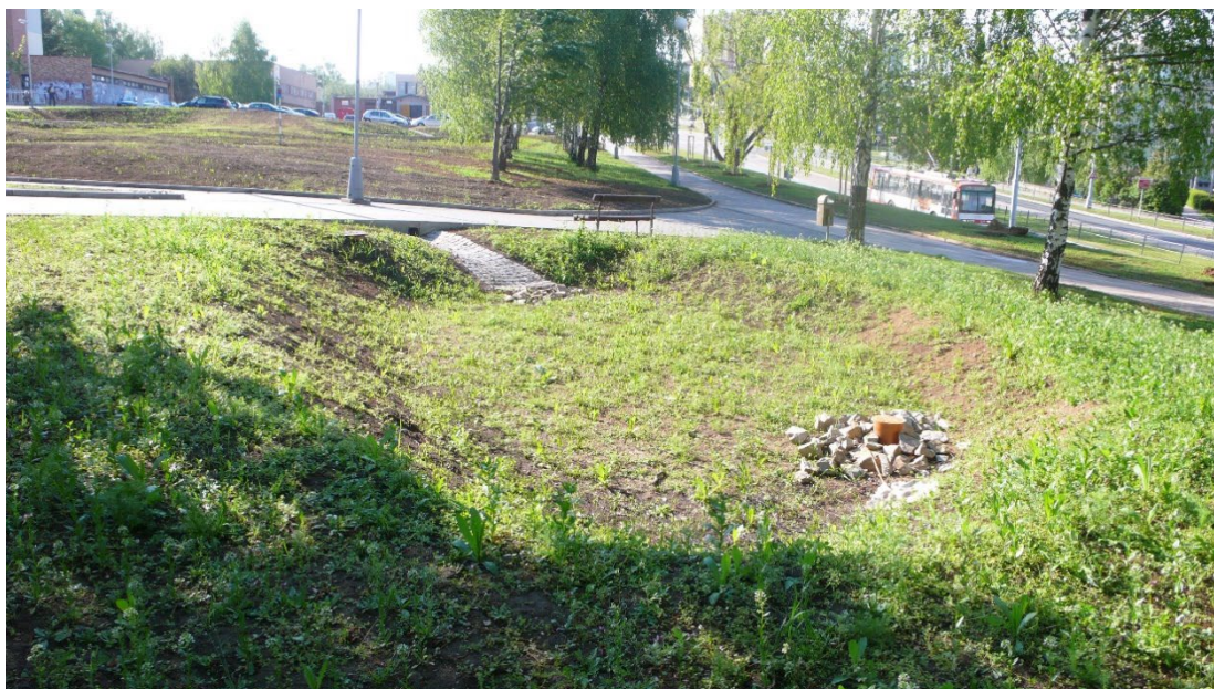
Obrázek 5: Vsařovací průleh po dokončení
