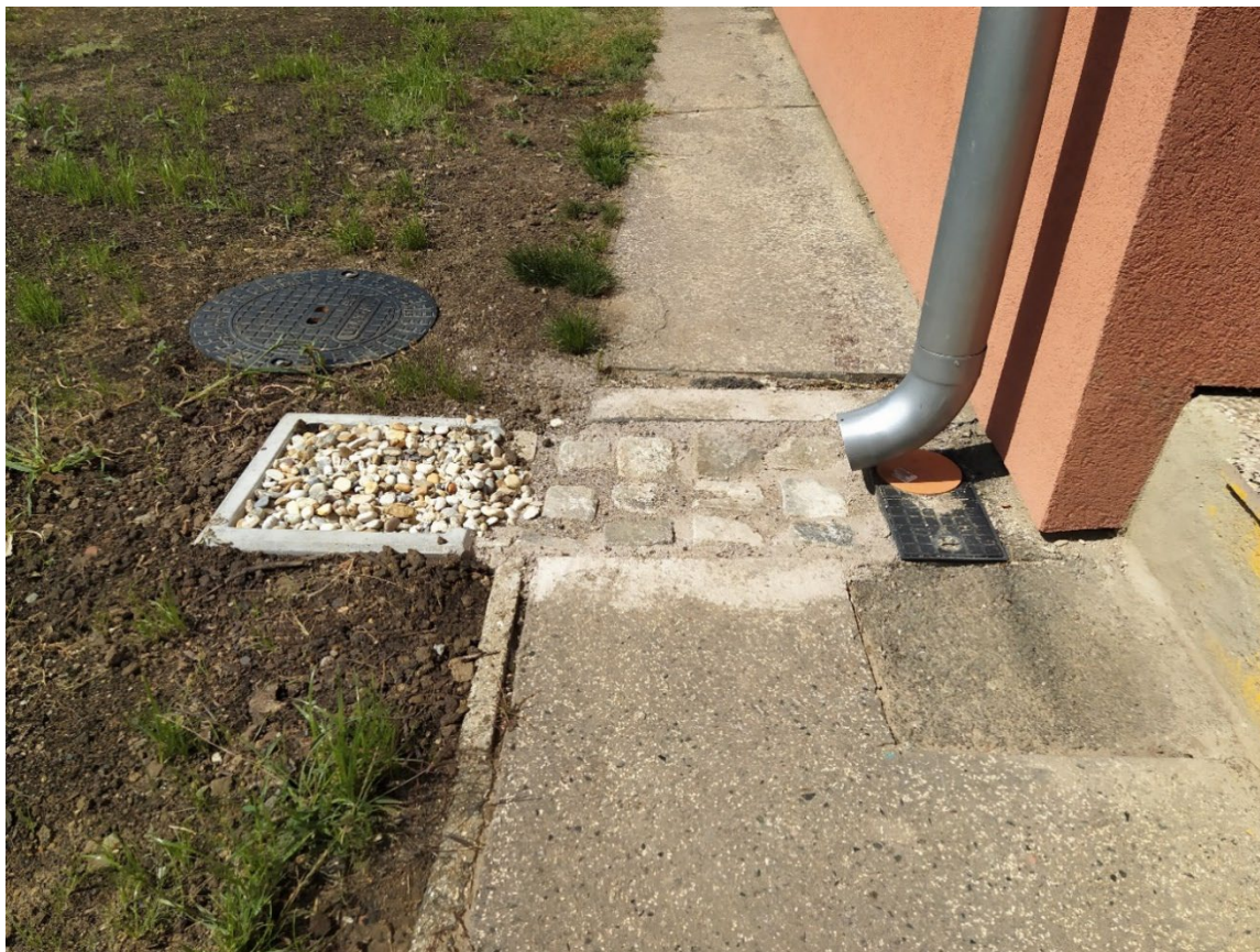
Obrázek 18: Zaústění do filtru střešních splavenin
