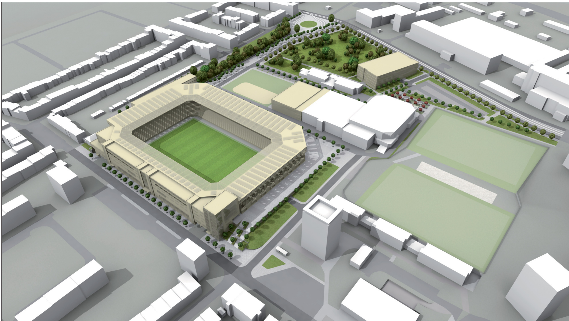
CELKOVÝ POHLED NA ŘEŠENÉ ÚZEMÍ OD SEVEROVÝCHODU
