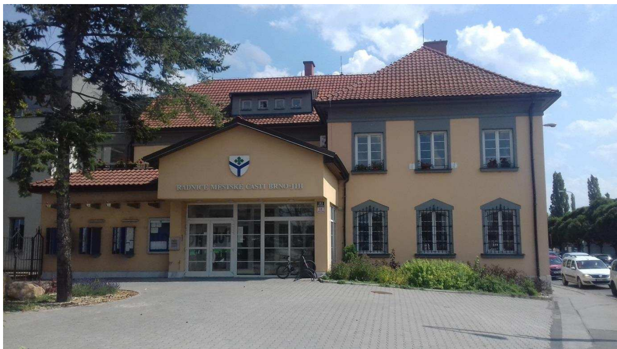
Obrázek 2: Budova ÚMČ Brno – jih
