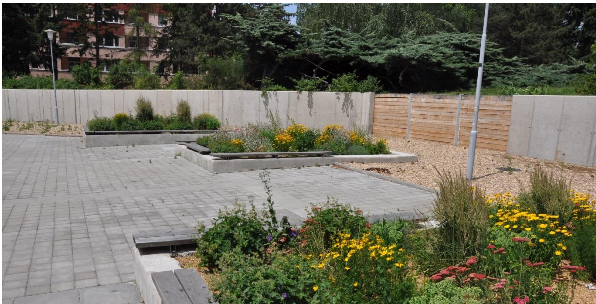
Obrázek 6: Opěrná zeď s vynechanými segmenty pro uvažované propojení
