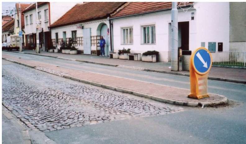
Zastávka autobusu s fyzickým oddělením (zátka) na komunikaci v Brně – Komíně. Výšková úprava ostrůvku umožňuje vjezdy do přilehlých objektů.
