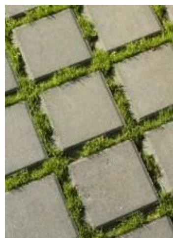
zatravnovací beton. dlažba
