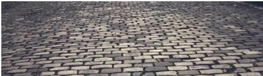
kamenná dlažba maloformátová na vazbu
