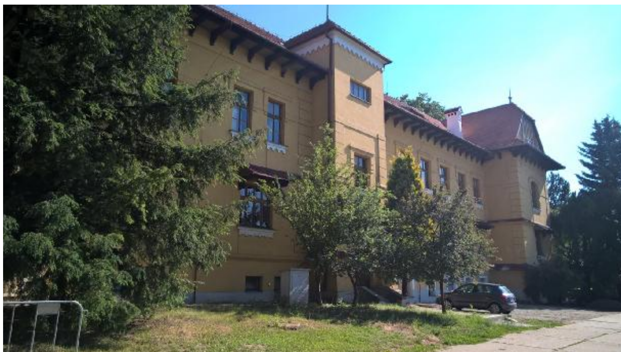
4. Budova bývalého Pomologického ústavu, pak střední zahradnické školy, dnes ZŠ Five star Montessori - jižní průčelí (kulturní památka)
