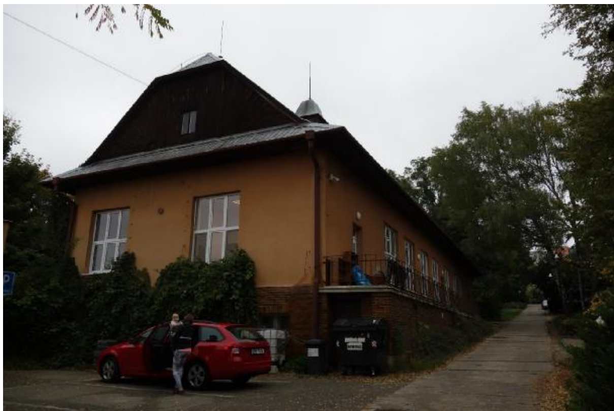
8. Objekt bývalé konzervárny, nyní MŠ Montessori (jižní část – na foto) a sídlo firmy
