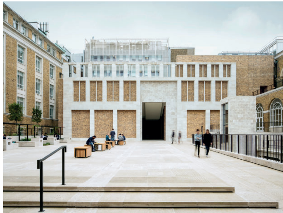
DLÁŽDĚNÝ PROSTOR PŘED STAVBOU VEŘEJNÉ VYBAVENOSTI
