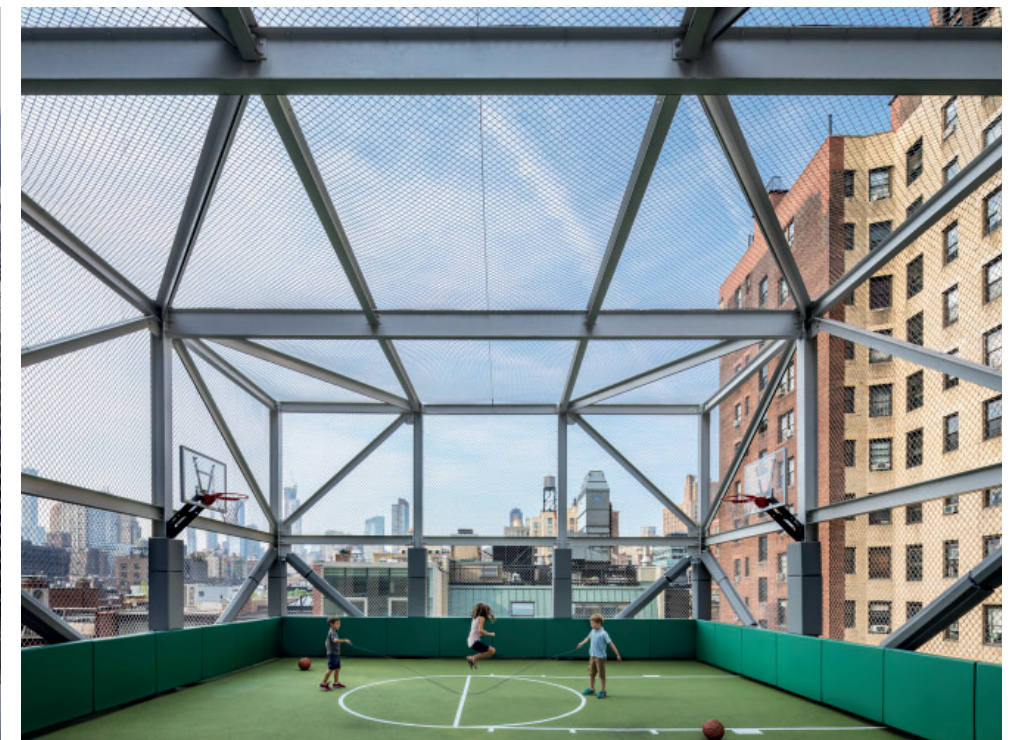
KONSTRUKCE SPORTOVIŠTĚ NA STŘEŠE ŠKOLY V INTENZIVNÍ ZÁSTAVBĚ
