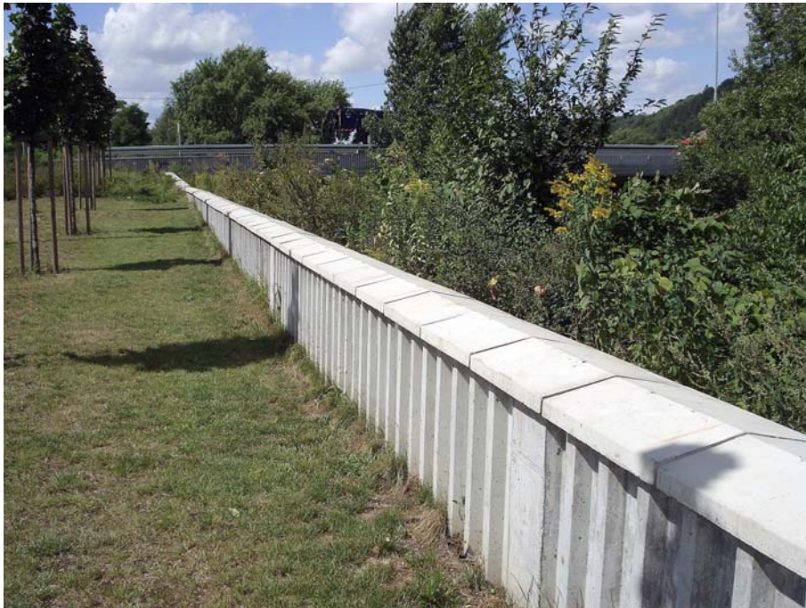
Obr. 4.6. Ukázka železobetonové protipovodňové zídky s členěným povrchem (Praha – Holešovice)
