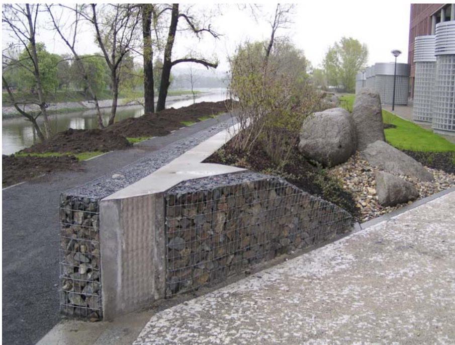
Obr. 4.7. Ukázka železobetonové protipovodňové zídky v kombinaci s gabiony a parkovou úpravou (Praha – Karlín u objektu Prague River City)
