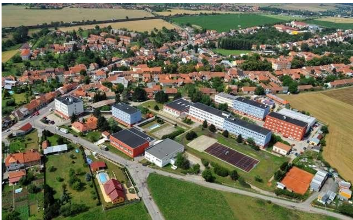
Obr. 3 Pohled na areál učiliště Střední školy stavebních řemesel Brno – Bosonohy. Rozlehlý areál mezi ulicemi Mlaty, Pražská a Skalní poskytuje vzdělávací i doplňkové služby jako je ubytování apod. Měřítko staveb stejně jako u areálu bývalého Transgasu kontrastuje s měřítkem rezidenční zástavby.
