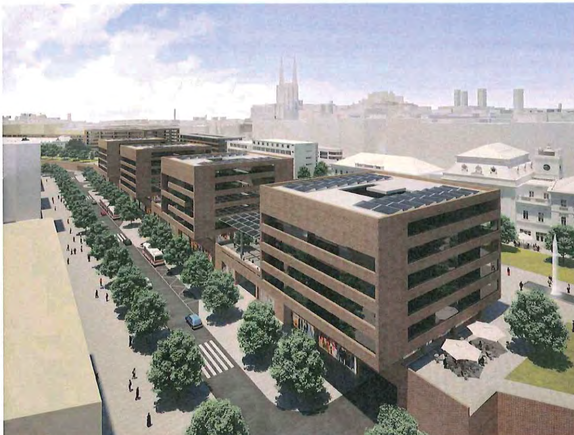
Urbanistická část 09 - po dokončení přestavby ŽUB - centrální polyfunkční zástavba na Uhelné
