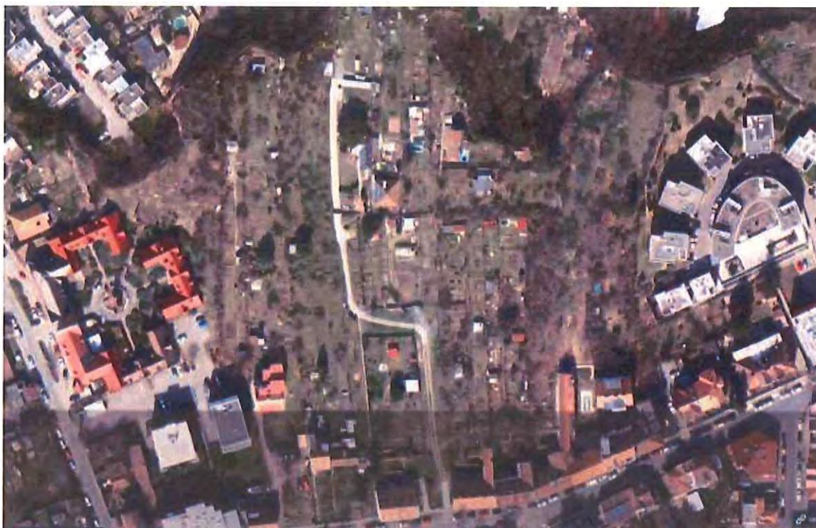
Obrázek 8- stávající stav účelové komunikace v dané lokalitě
