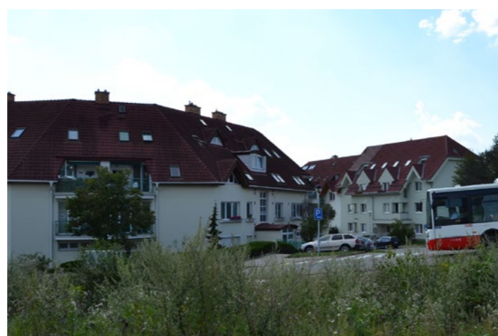
Bytové domy z 90. let podél ulic Kociánka, Žleb, Mojžíšovy a Högerovy
